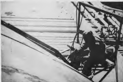
To parse out mabera cu Rupert Fiory la carta a tanki haa di su meti cuerpo. Pero loke e ta haci ta di haa e pashionan pa desarraha e tanki. E aparato cu e ta usa aha ta construi aki mes especialmente pa e trabao ay. E ta traha di barinan di steel pavidu as otro y e tin un ma de pa e corce rond di e tanki segun cu e trabao ta kama e pashionan.
